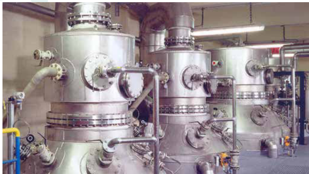
Abbildung: Eindampfanlage
